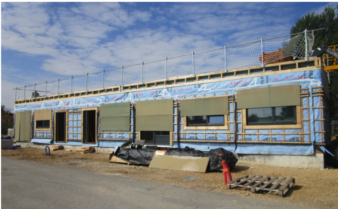
Projet Chênelet – chantier en cours
